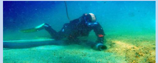
Buceador dirigiendo la tubería de succión para retirar el sedimento
